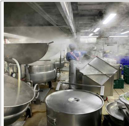
그림 43 학생회관 조리작업 시 환기 상황1
