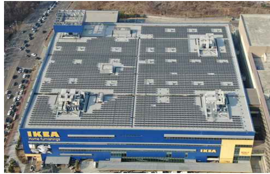
<이케아 광명지점 지붕 위의 태양광>
