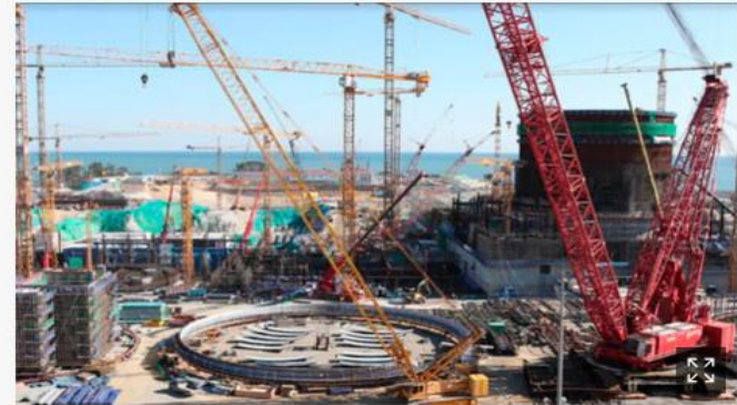
신고리 5·6호기 공사 현장.
