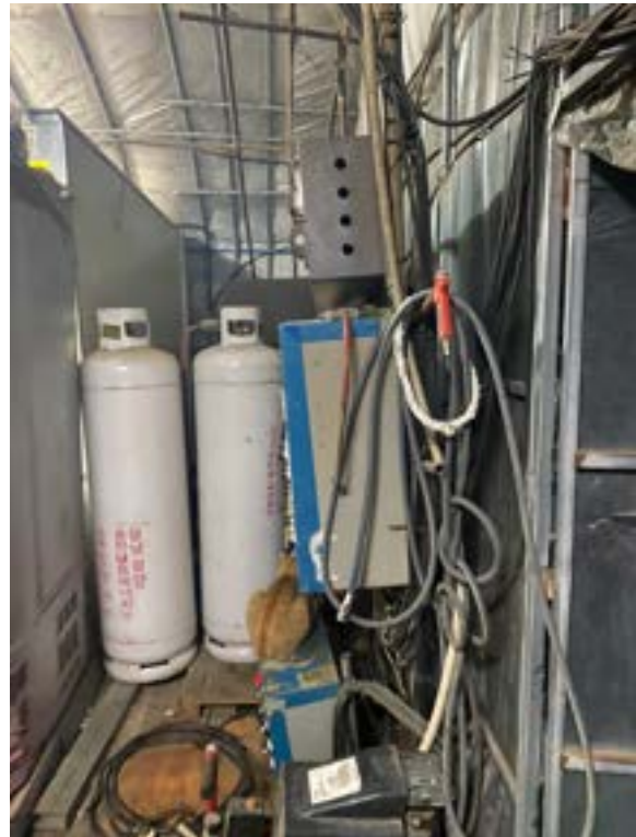
[사진 12] 화재 위험이 있는 이주노동자의 숙소. 여기저기 LPG가스통이 있으며 배선들이 엉켜있다. © 우춘희
