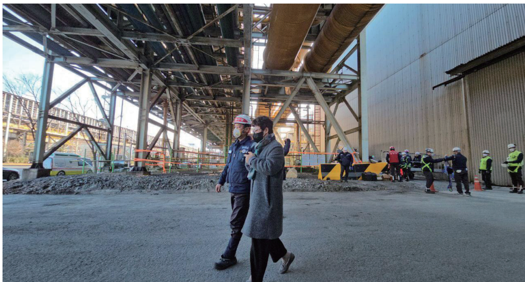
▲ 유가족과 현장 조사 중인 정재윤 노안1부장(왼쪽). 위쪽의 배관이 사고가 난 LDG 배관이다. 사진 : 백승호
