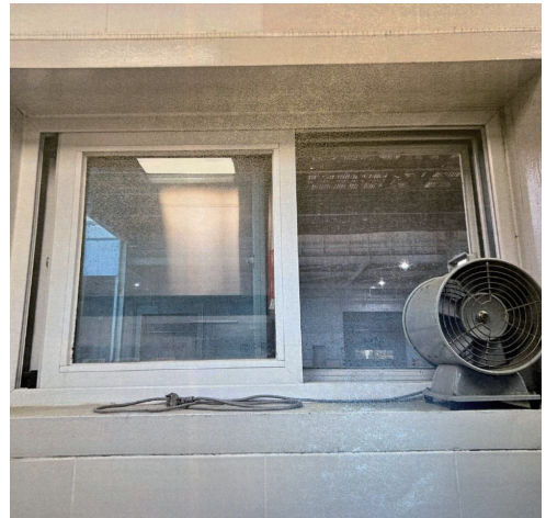
▲ 현대자동차 전주공장 트럭식당의 세정실 내부 전경. “열악한 통풍 및 환기 여건 좀 바꾸자고 저 창문 하나 내느라 4년이 걸렸어요.” 사진 : 현대그린푸드전주지회
