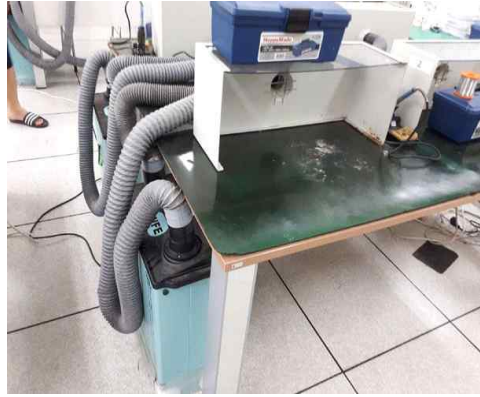
그림 59. 배기설비 없이 납땀하는 학생 그림 60. 책상마다 설치된 납땀용 후드
