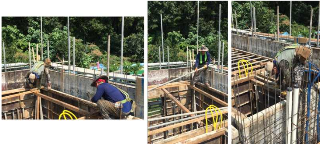
그림 82 위험한 천장 각제, 파이프 고정 작업(주택)
