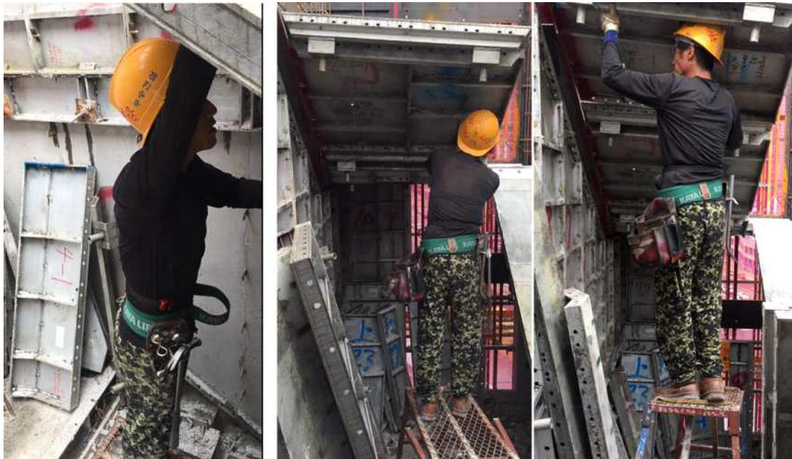
그림 95 계단 천장 조립 작업
