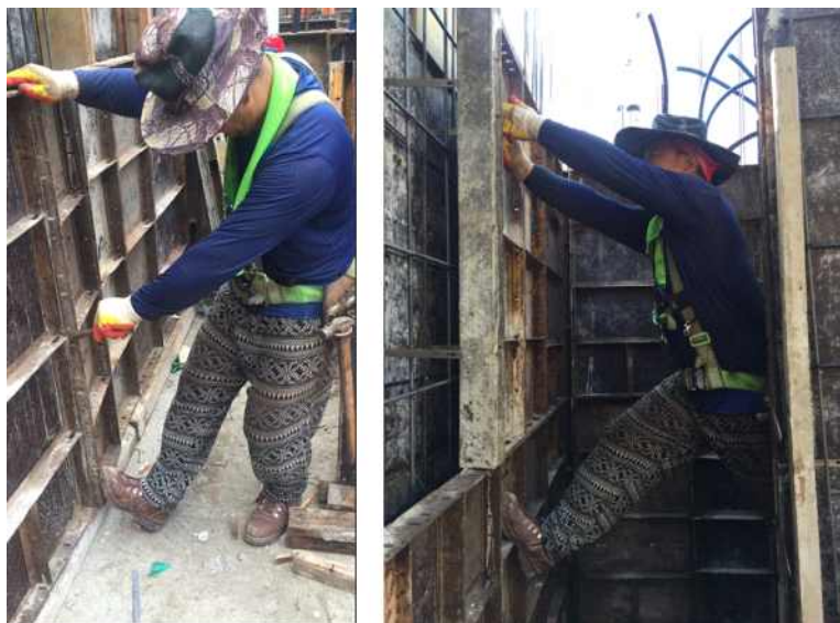
그림 79 벽체 유로폼 조립 작업(주택)
