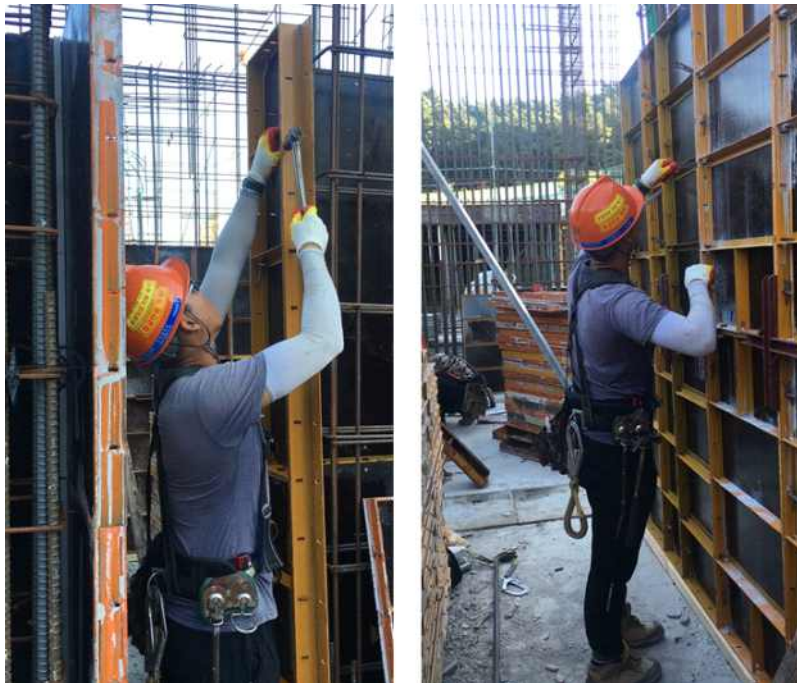
그림 74 아웃코너 조립과 플랫타이 조립
