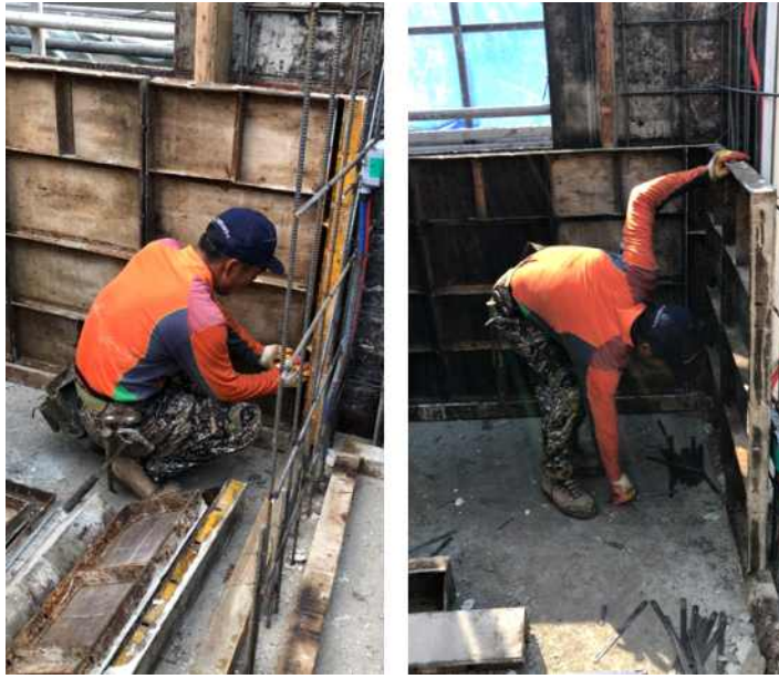
그림 85 인코너 및 유로폼 조립
