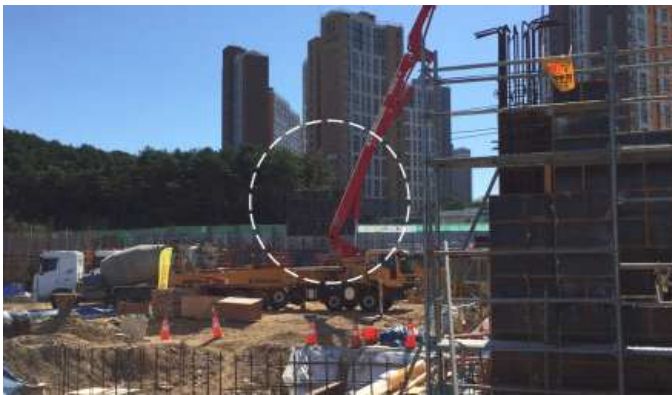
그림 55 조립 후 크레인으로 설치되는 외벽(야기리)
