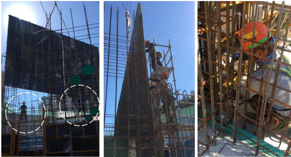
그림 67 외벽(야기리) 설치 및 고정 작업
