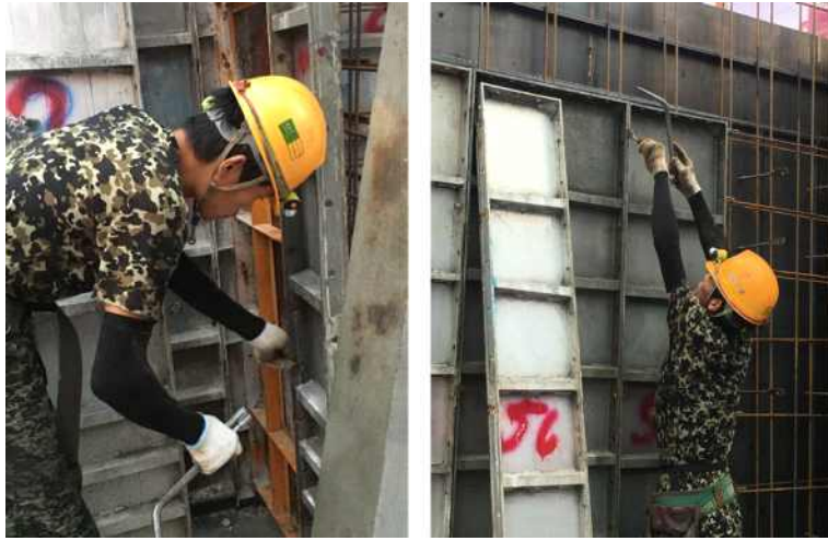
그림 100 알폼 조립 작업
