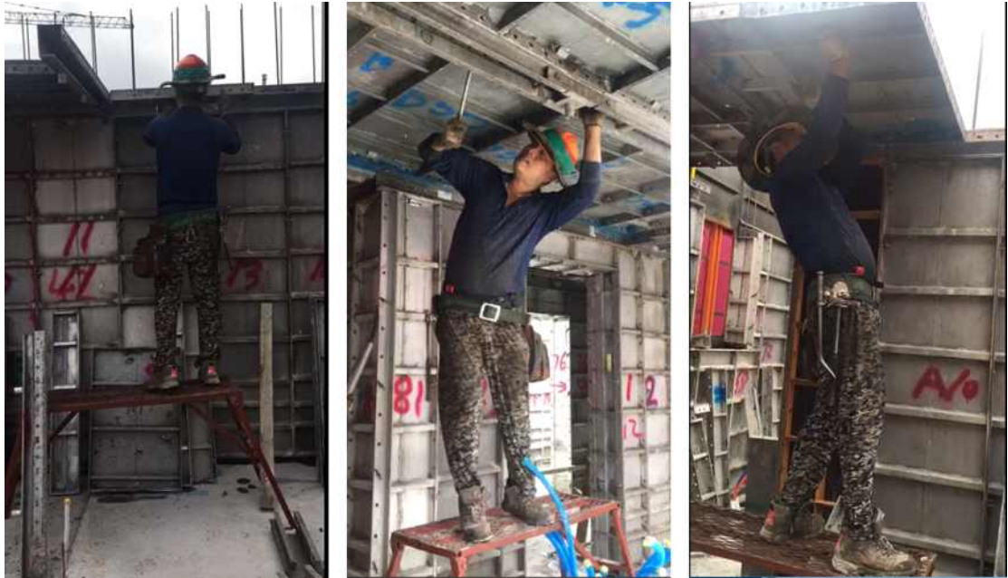
그림 103 알폼 천장 조립 작업
