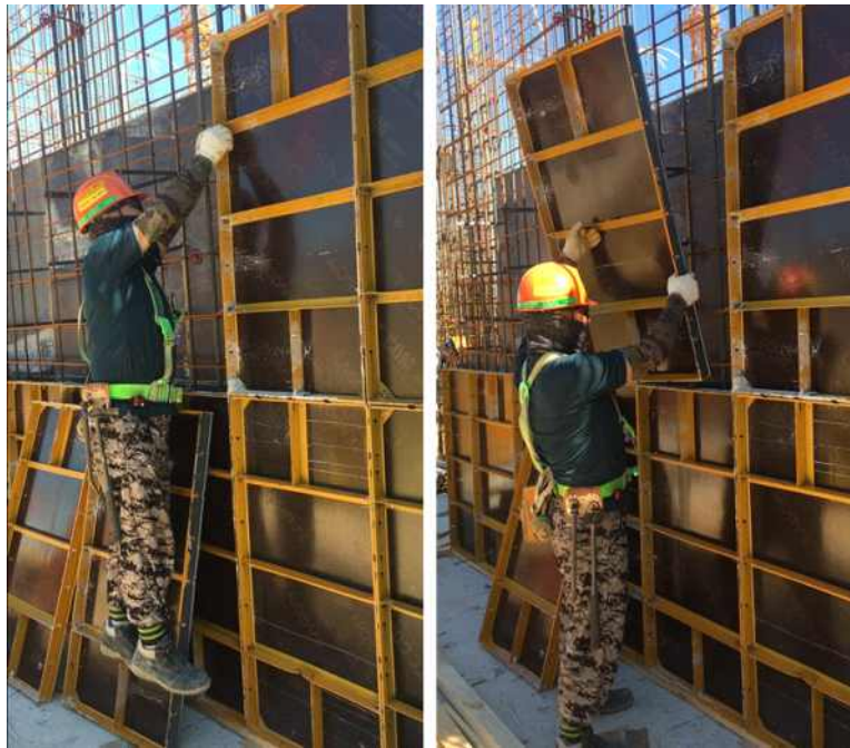
그림 69 불안정한 자세로 하는 2단 유로폼 조립
