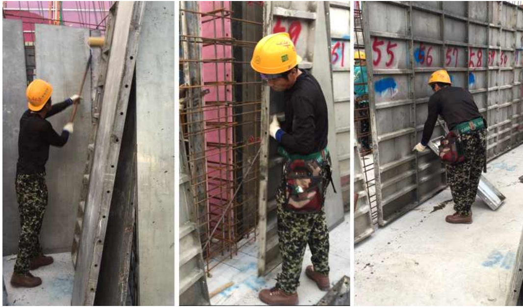
그림 91 박리제 도포, 알폼 뒤집기, 알폼 조립
