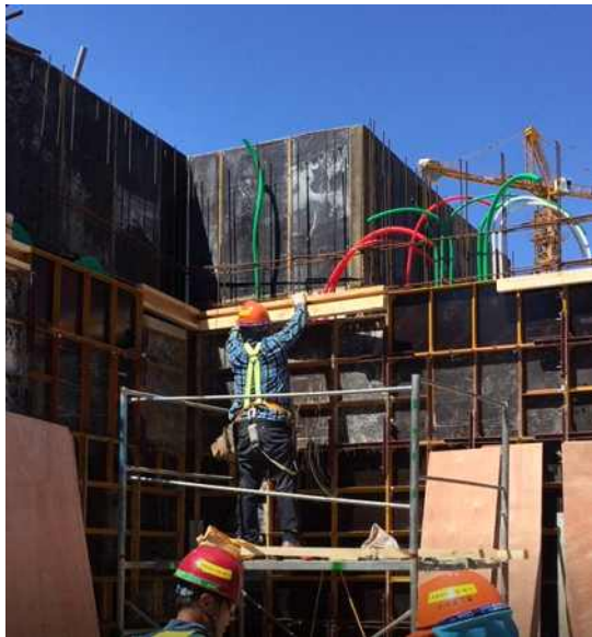
그림 32 거푸집 보강 조립
