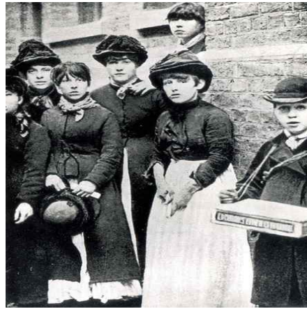
19세기 영국 런던의 성냥 공장 여성노동자
