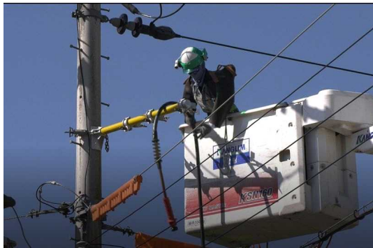
▲ 바이패스 단말 케이블을 특고압 전선에 연결하기 전 케이블을 가지지 크리트에 잡아주기 위한 작업
