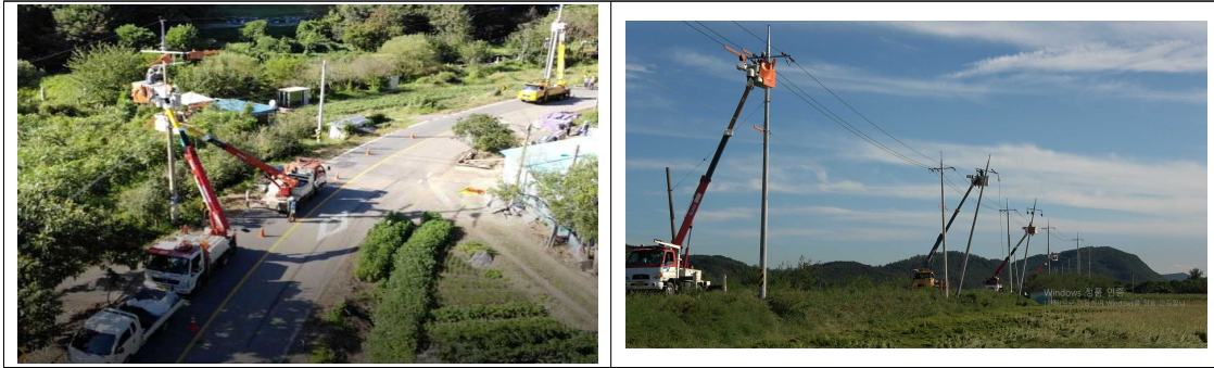
그림 23 전주별로 작업 중인 활선공
