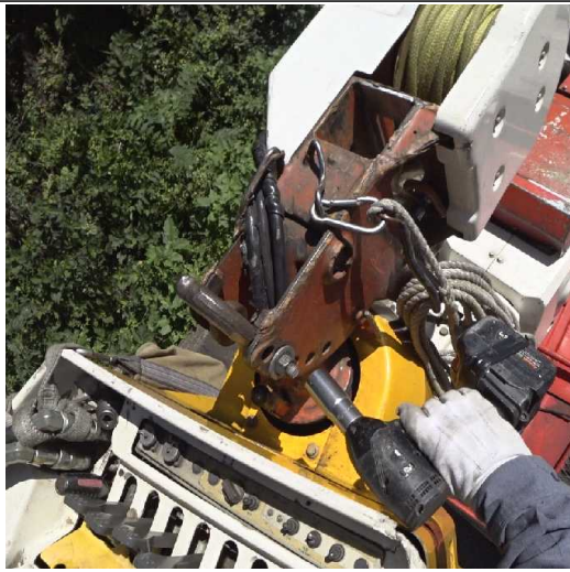
▲ 전기 임팩트를 사용하는 작업 모습
