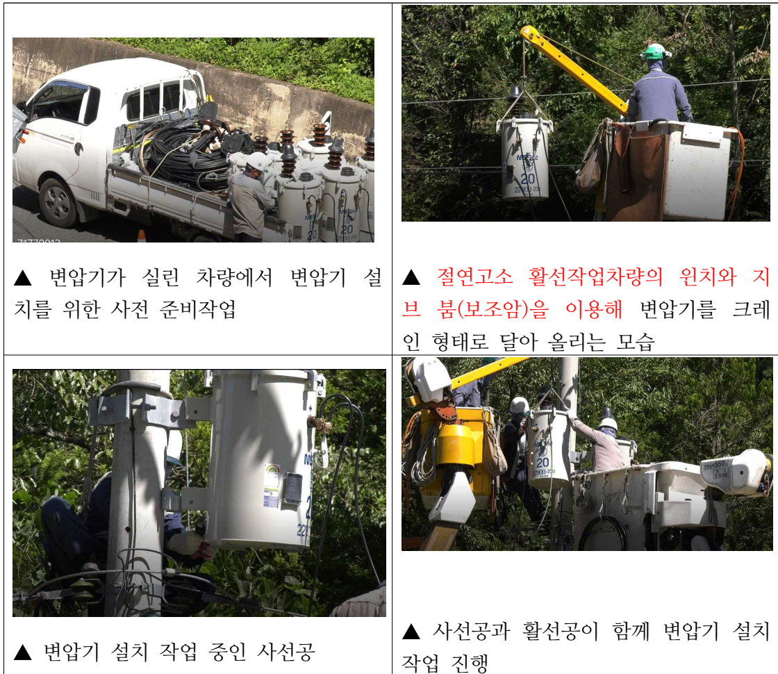
그림 9 변압기 설치 작업
