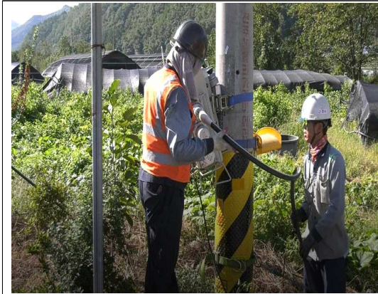
▲ 작업 시작 구간에 임시 공사용 개폐기에 바이패스 케이블을 설치함
