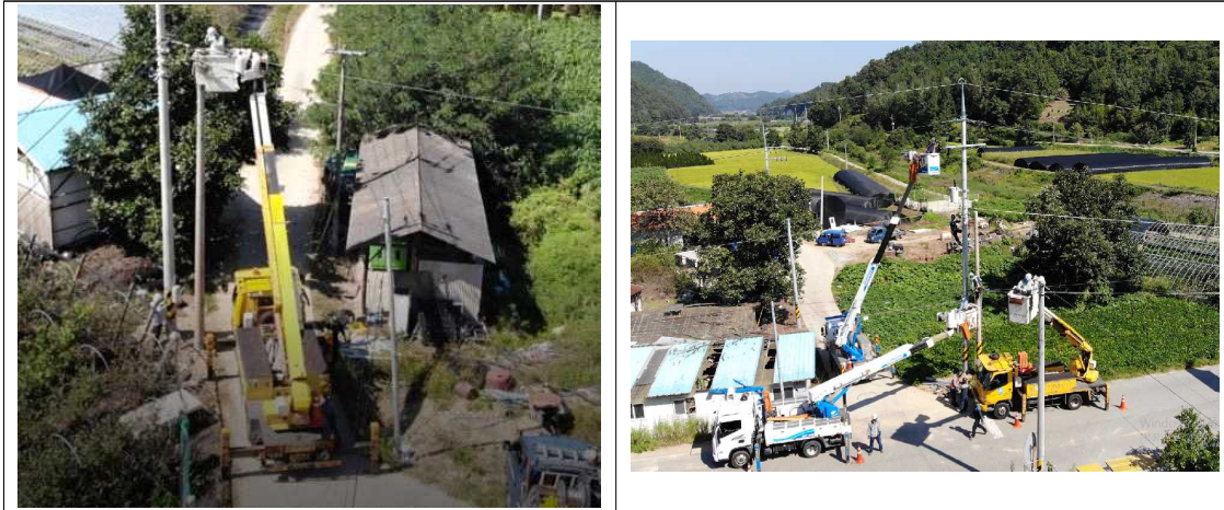
그림 20 협소한 작업 현장
