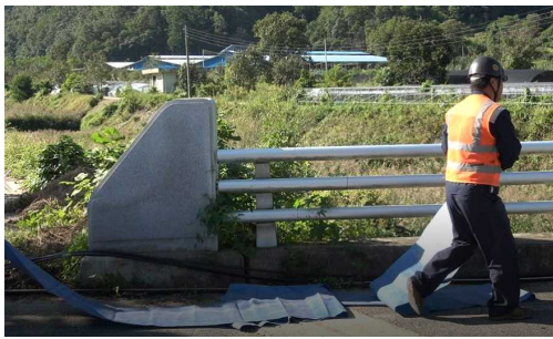
▲ 바이패스 케이블이 손상되지 않도록 보호 천막(또는 부직포)을 펼쳐놓는 작업2
