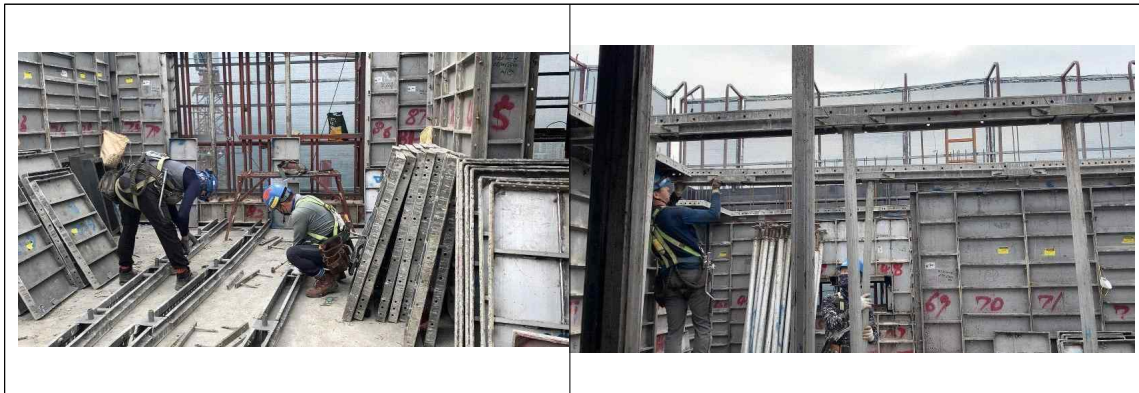
그림 23 지지대 조립과 설치
