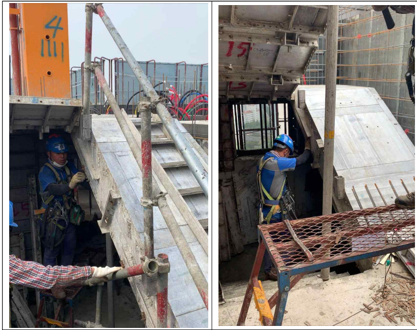
그림 31 계단 난간쪽 경사면 설치
