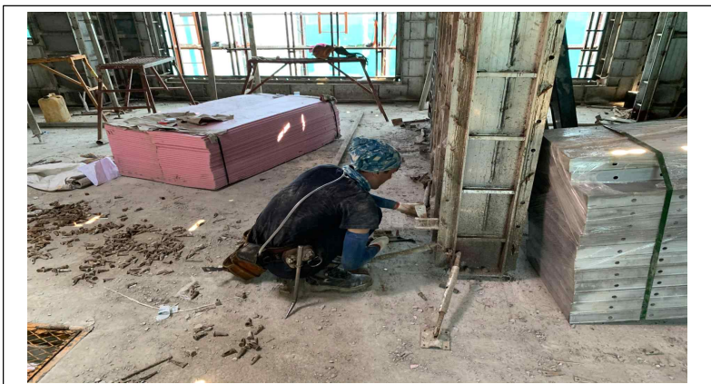
그림 39 하부자키 등 벽체 하단 마무리 작업
