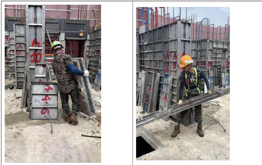
그림 10 두 번째 받아치기 작업과 폼 이동 ③ 천장 조립
