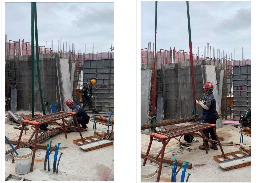
그림 8 작업 중인 현장에 남아 있던 철근 묶음 운반
