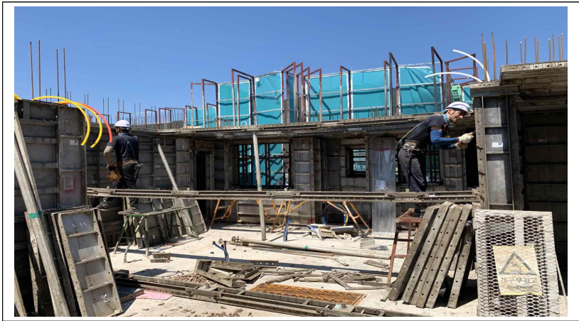
그림 38 미드빔 및 천장 알폼 조립 작업
