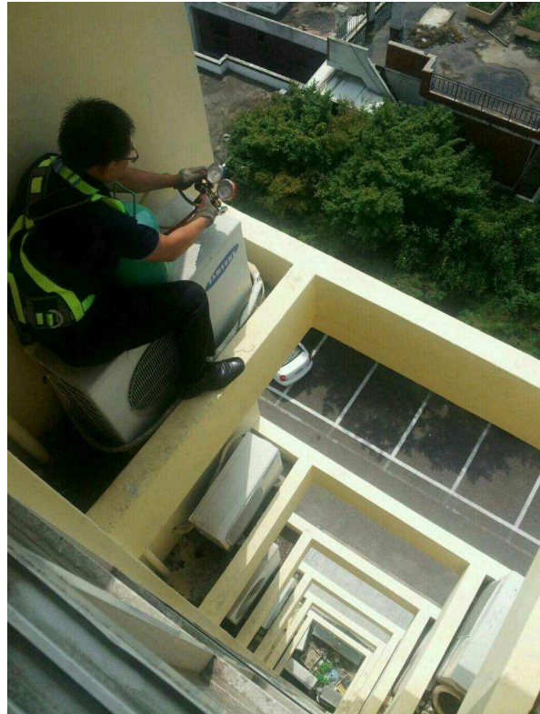
(그림2. 철제난간에 매달려 있는 에어컨 실외기) (그림3. 공동주택 냉방설비 배기장치 공간의 실상)
