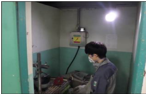
사진10. 용접부스 내 용접작업
